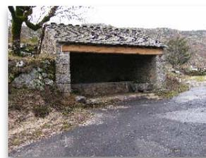
les ABPS Thomas Brasseur, Bruno Durand ont réalisé ces travaux entièrement. Il s'agissait de reprendre les margelles, banc, goulottes en granit de ces fontaines et abreuvoir ainsi que le remplacement de la poutre principale pour la fontaine du village.
