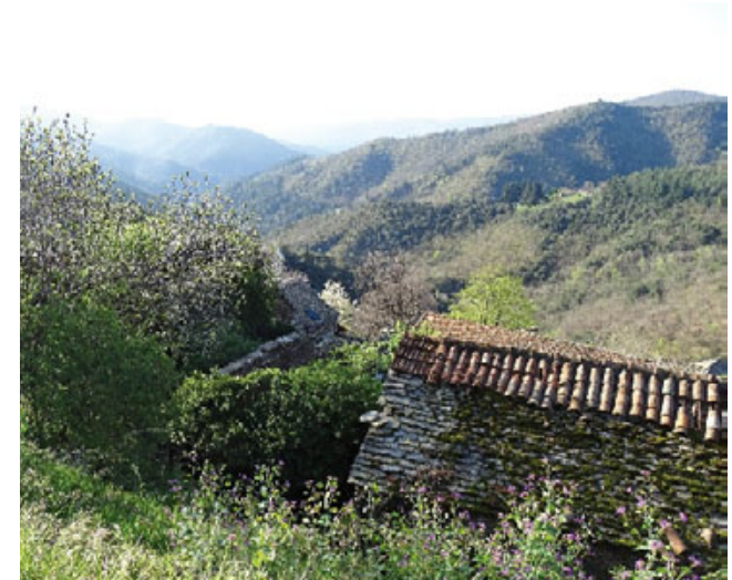
Utilisation de la tuile canal sur du bâti ancien
