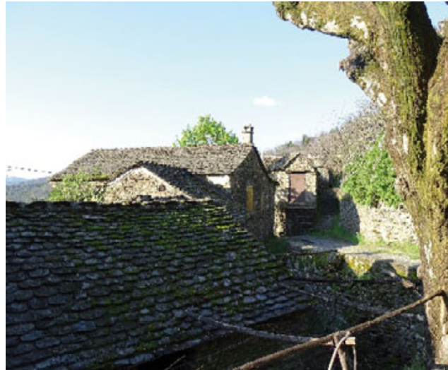
Toiture en Lauze avec faîtage à rastel
